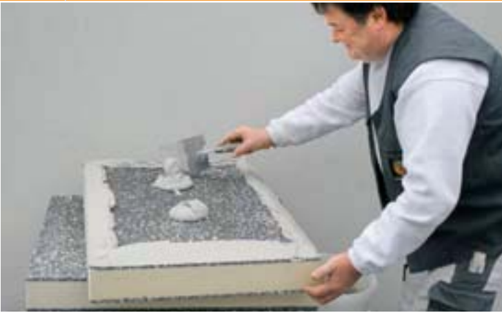
Auftragen des Klebers in der bewährten Punkt-Wulst-Methode
