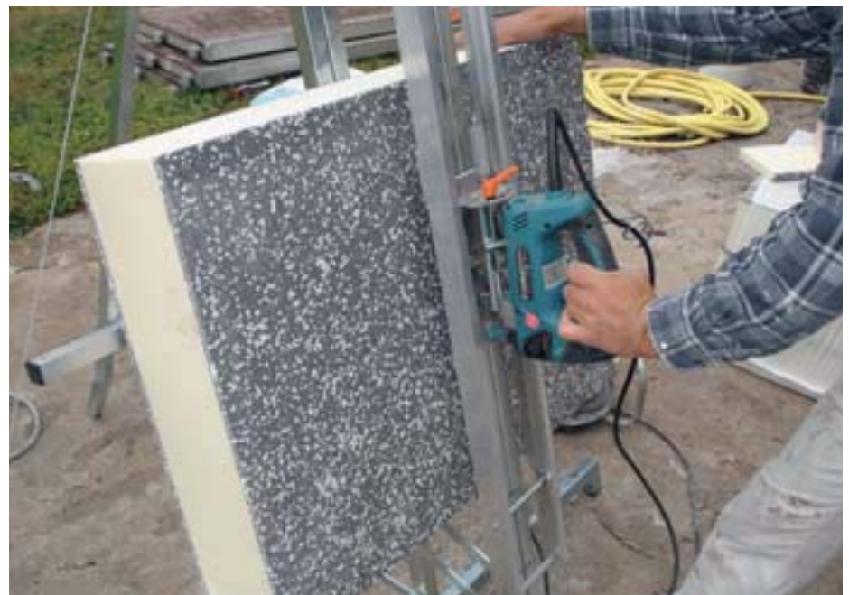
Die neue Dämmplatte lässt sich mit einer Säge leicht zuschneiden.
