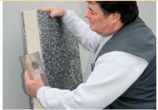
Auch ein nachträgliches Schleifen der Oberfläche gelingt mit der Dalmatiner-Fassadendämmplatte S 024 problemlos.
